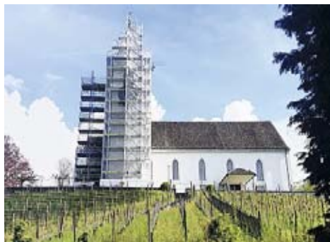
Renovation des Kirchturms in vollem Gange.
