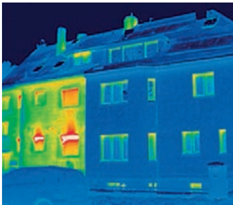
Mangelhafte und optimale Energieeinsparung.
